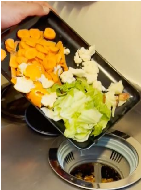
Die Bioabfälle werden in der Spüle in den dort eingebauten Biospüler eingeschüttet.
